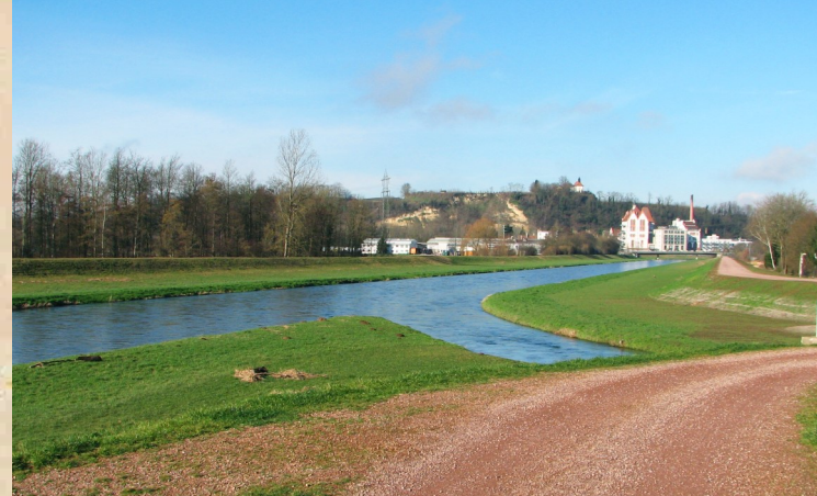
... im ausgebauten, begradigten Doppeltrapezprofil ...
