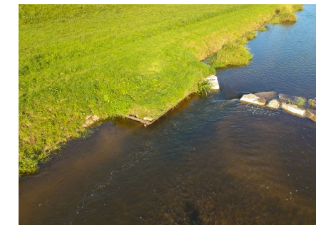
Fischunterstand mit Steinbuhne
