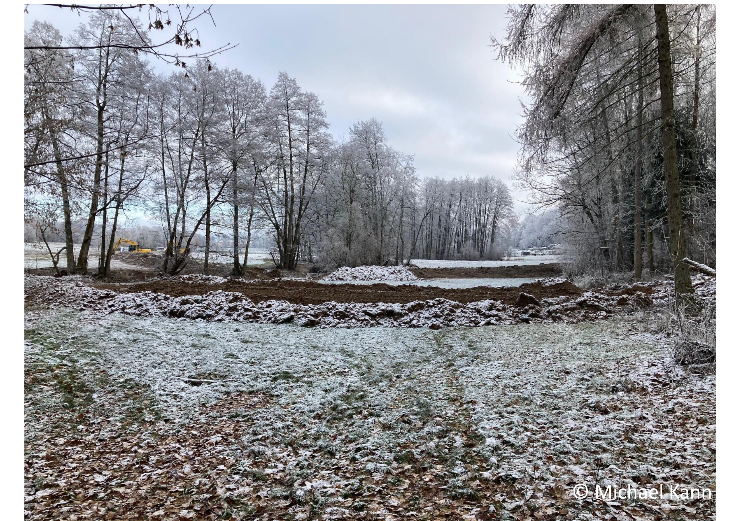
Aufschütten von Vorlandwällen
