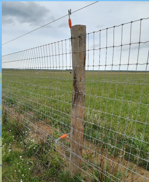
Ausführung Prädatorensperrowerk
