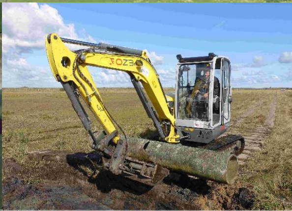
Instandsetzung Rohrdurchlässe
