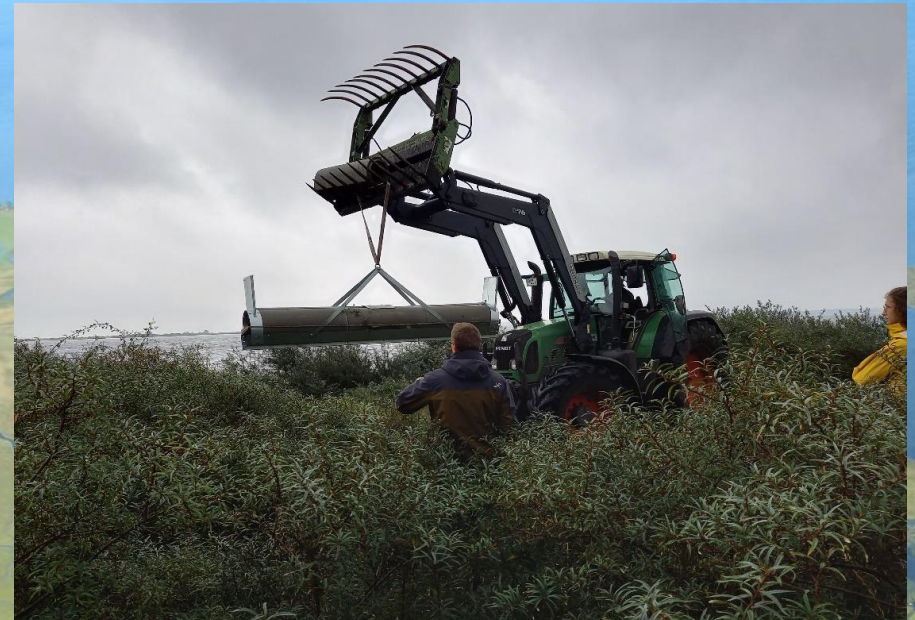
Einbau Betonrohrfalle
