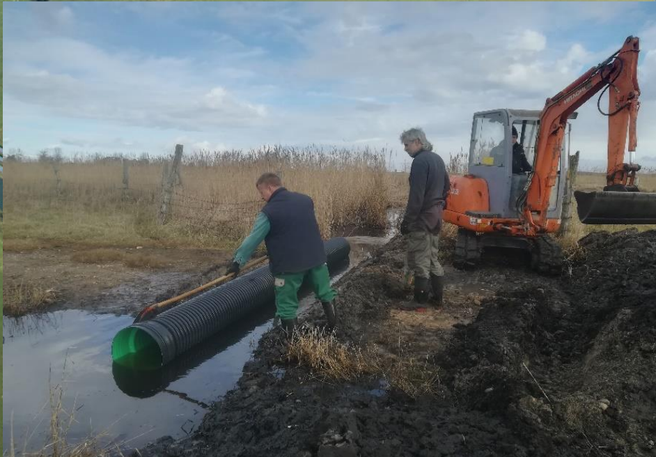
Instandsetzung Durchlass
