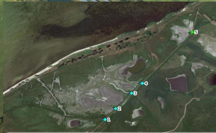
Instandsetzung Rohrdurchlässe, Tieferlegen Furt
