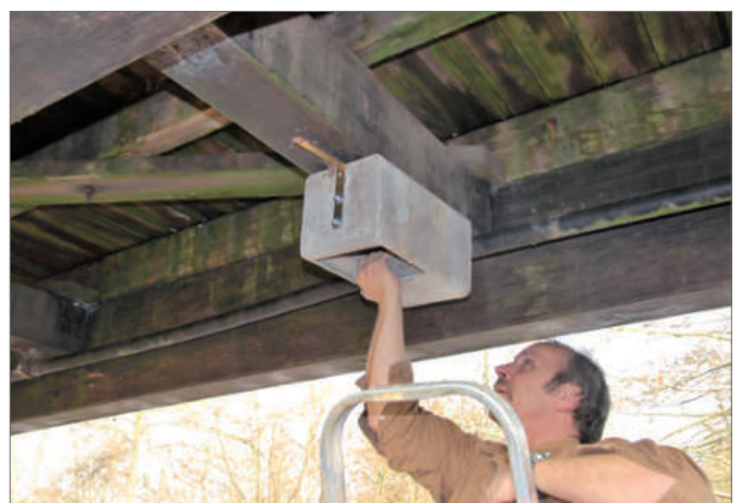
Wasseramsel-Nistkasten-Montage unter Brückenbauwerk
