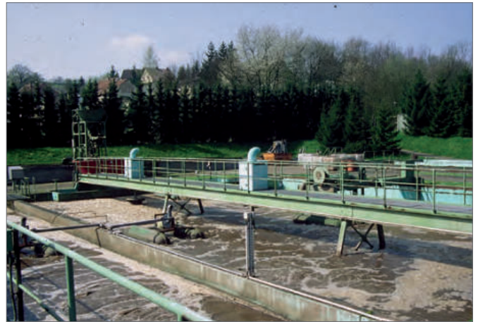
Kläranlage Illingen-Wustweiler: alter Zustand
