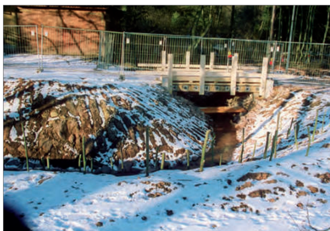
Holzbrücke statt Verrohrung über dem Klingelfloß
